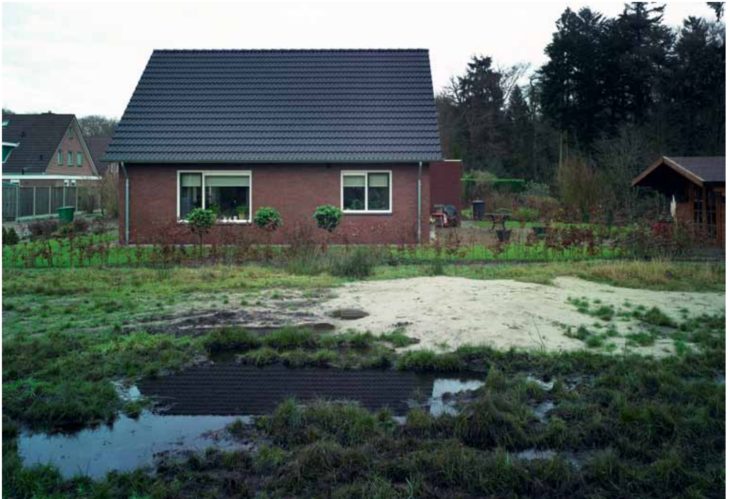
Nieuwbouw, met op de voorgrond de laatste bouwkavel. Daarna kunnen appartementen gebouwd worden in vrijkomende boerderijen.
