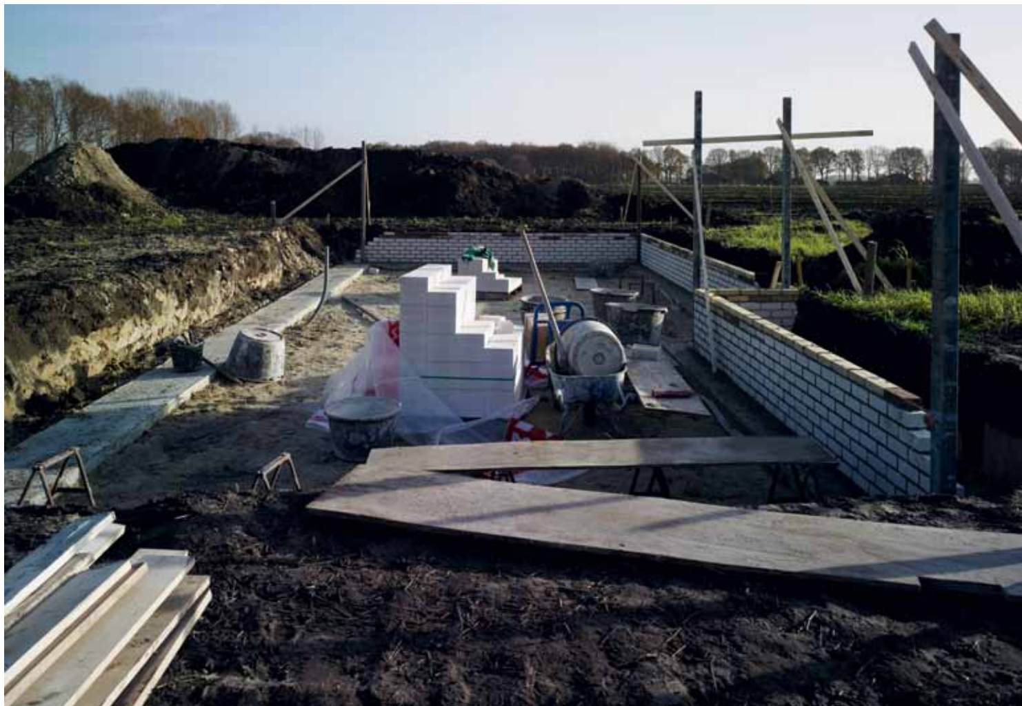
Fundament voor een van de 62 nieuw te bouwen koloniewoningen. De erfpacht daarvan wordt waarschijnlijk de grootste inkomstenbron.
