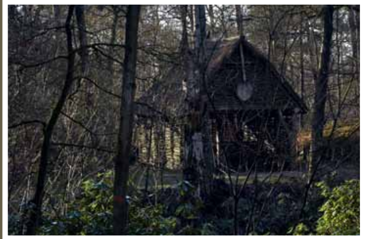
De kluizenaarshut van Landgoed Vilsteren kreeg ineens een huisnummer.
